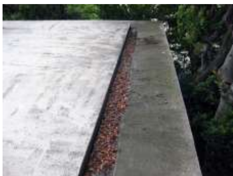
展示室・収蔵庫棟屋根清掃
