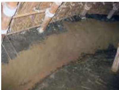
復元住居壁面の修繕
