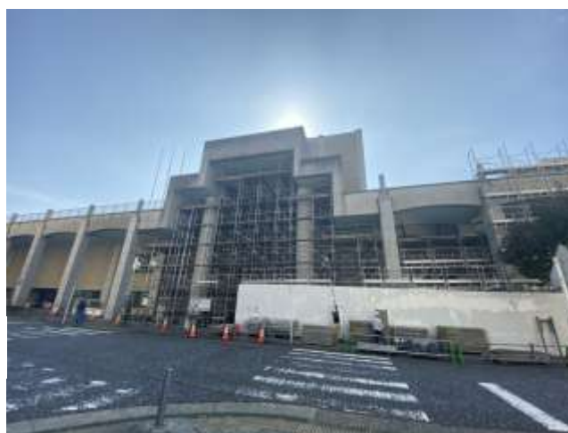
・壁・天井改修工事にともなう脚場の組立
