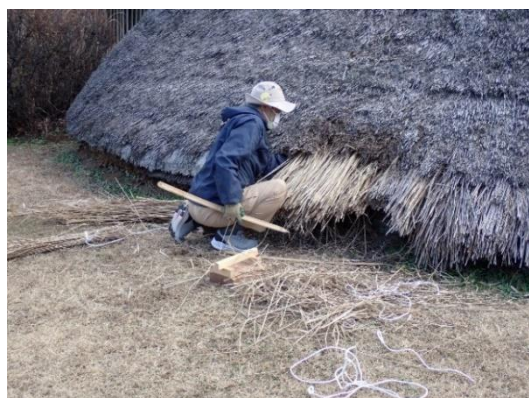
茅葺き屋根プロジェクト Y74 住居の修繕
