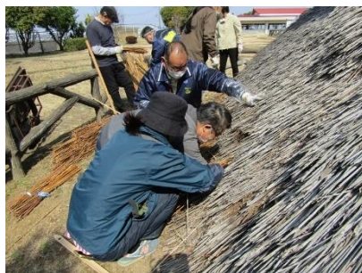
復元住居 茅屋根の補修
