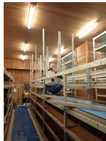
収蔵棚増設工事
