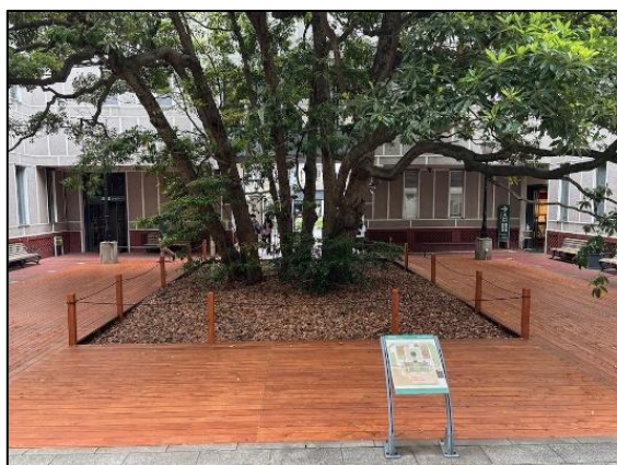
完成したバリアフリーデッキ
